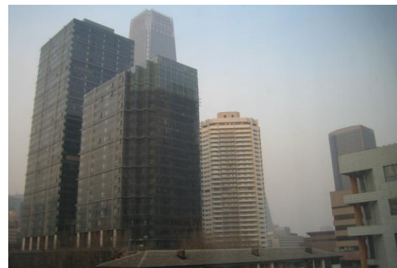
図 2.3.3-3 今だ建設途中の北京中心の 近代的商業、オフィスビル
